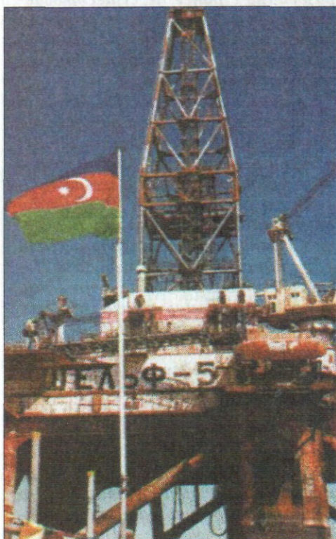
Азербайджанские нефтегазовые комплексы (на снимке сверху – компании «Гюнешли», внизу – вблизи г. Баку)
